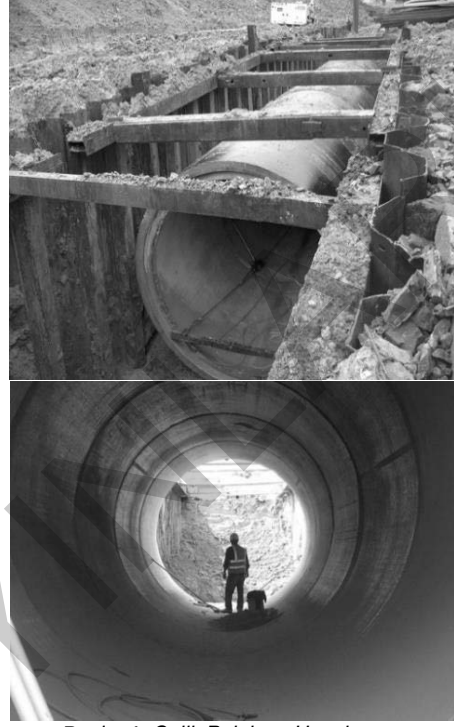
Resim 1. Çelik Palplanş Uygulaması (Küçükçekmece Eşkinöz Deresi/ASM İnşaat)
