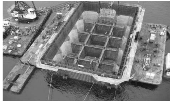
Resim 1. Açık Keson Uygulama Örneği
