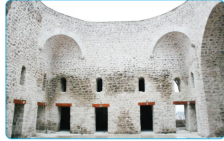
Yağlıbasan Medresesi (Danişmentliler)
